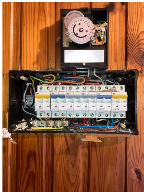
( Elektrisch bord - binnenkant )
