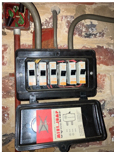
( Elektrisch bord - binnenkant )
