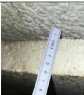
Isolant plafond garage
