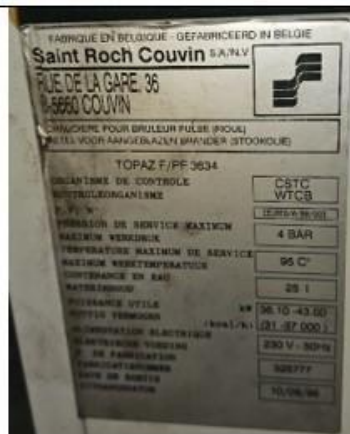
Plaque signalétique chaudière
