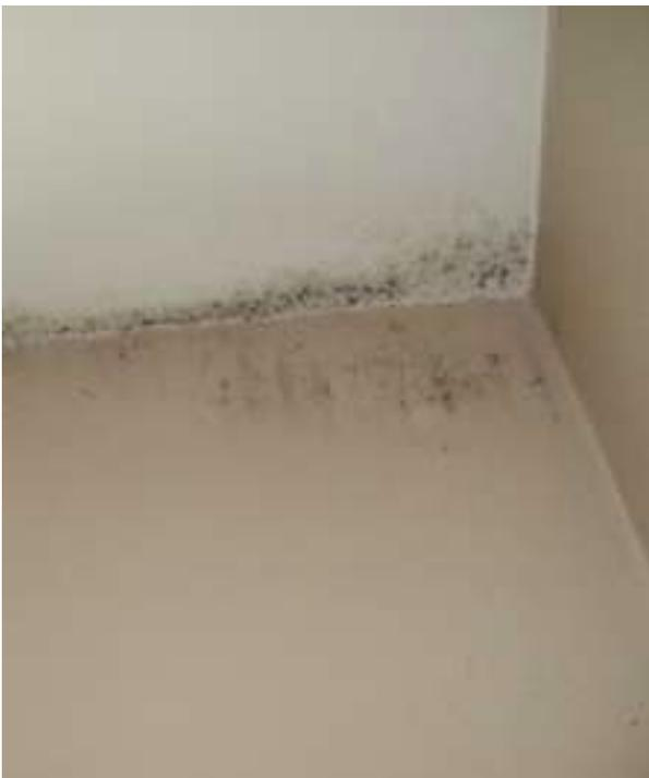
Les moisissures de condensation se présentent généralement sous la forme de traces foncées ou tachetées de points noirs. Elles se situent principalement sur le haut des murs, dans le bas de la paroi murale (pour le rez-de-chaussée) ainsi qu'autour des châssis et menuiseries.
