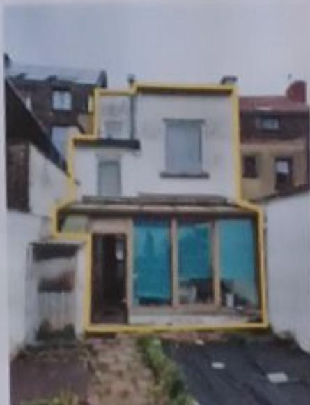
Le volume protégé d'un logement reprend tous les espaces du logement que l'on souhaite protéger des déperditions thermiques que ce soit vers l'extérieur, vers le sol ou encore des espaces non chauffés (cave, annexe, bâtiment mitoyen...). Il comprend au moins tous les locaux chauffés. Lorsqu'une paroi dispose d'un isolant thermique, elle délimite souvent le volume protégé.
