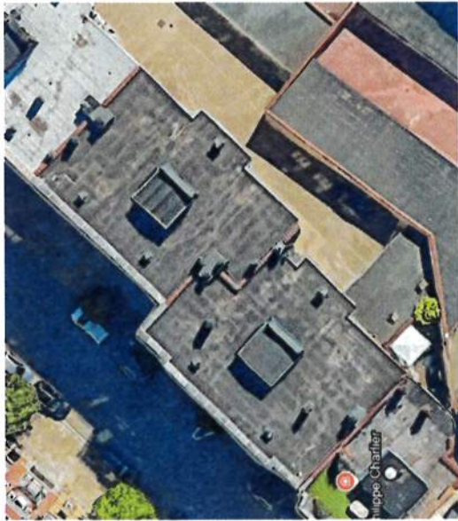
Figure 9 : vue aérienne de la toiture plate pour le potentiel photovoltaïque Tableau 1 : étude du temps de retour pour l'installation de panneaux photovoltaïques
