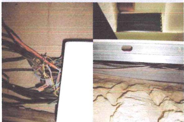
jusqu'à sa pénétration dans le matériel électrique qu'il alimente. Tous les fils électriques doivent être totalement inaccessibles.
